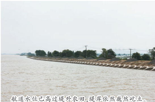
航道水位已高过堤外农田,堤岸依然巍然屹立。
