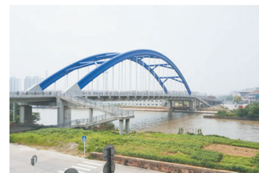
苏南运河三级航道桥梁工程(常州段) SNCZ-SG-QL2标金牛大桥日前通过竣工验收。
