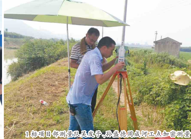
1标项目部测量队吴安守、孙盛德周成河工点加密测量
