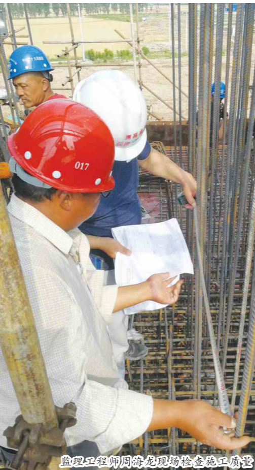
监理工程师周海龙现场检查施工质量
