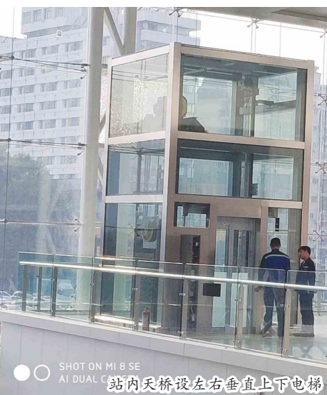
站内天桥设左右垂直上下电梯
